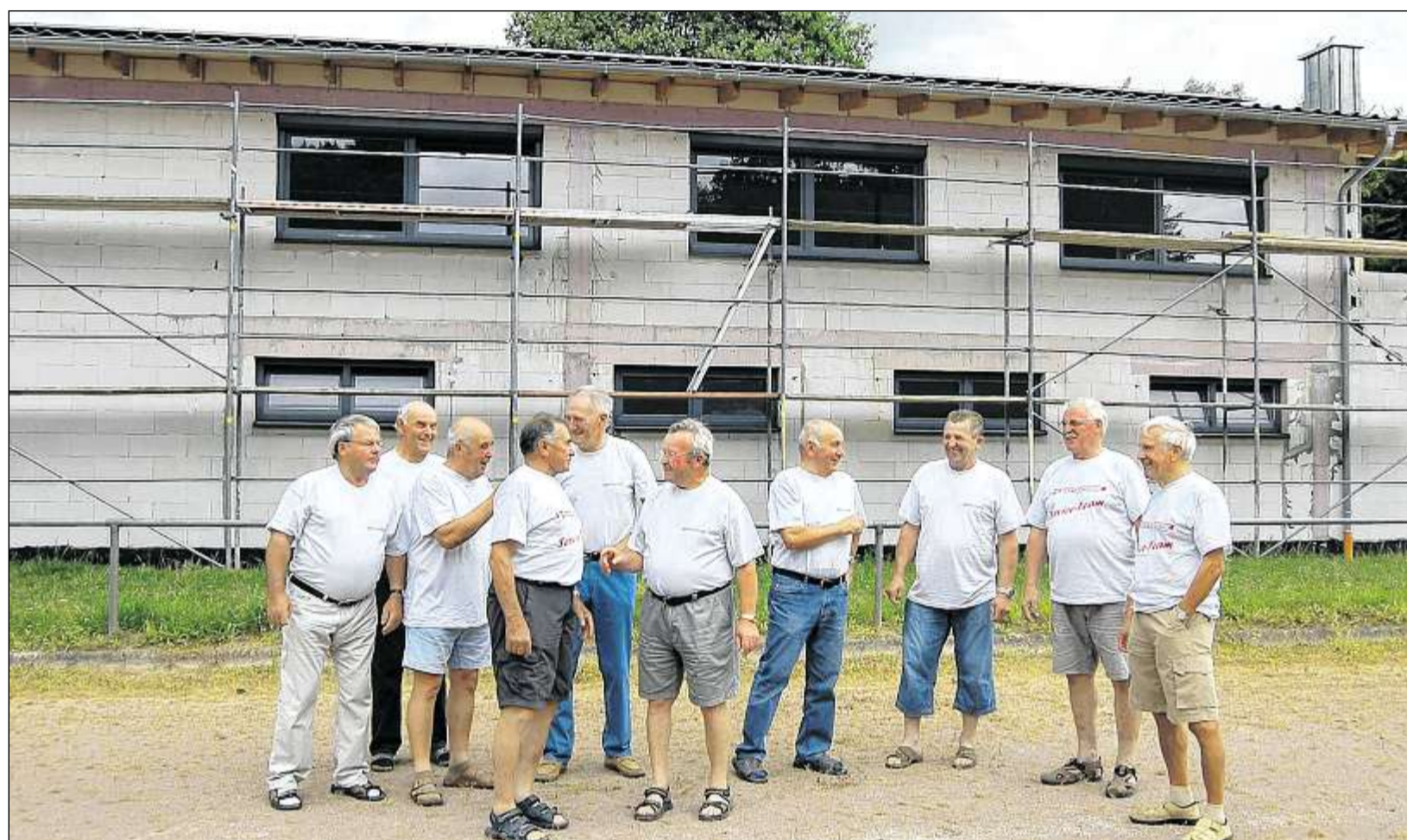
LEGTE KRÄFTIG HAND AN: Die „Rentnergruppe“ um Karl Nachbauer – hier bei der Fertigstellung des Rohbaus im vergangenen Sommer – war maßgeblich am Clubhaus-Neubau beteiligt. Alles in allem leisteten die Vereinsmitglieder 8 000 Arbeitsstunden. Archivfoto: Reif
